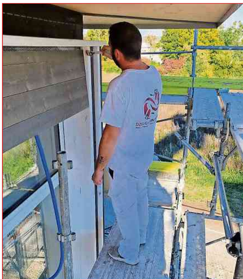
Maler Shukri Dzelili arbeitet am neuen Rümlanger HPS-Gebäude. Bild: zvg
